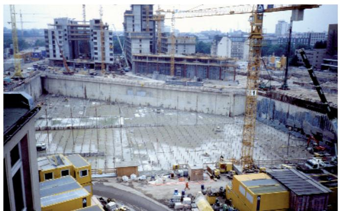
Abb. 3.3-3 bis 3.3-8 Herstellung einer Trogbaugrube mit Unterwasserbetonsohle am Potsdamer Platz
