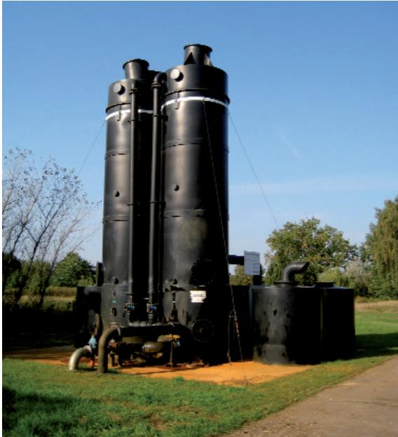
Abb. 5.2-5 Grundwasserreinigungsanlage am Wasserwerk Johannisthal
